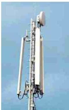
typische Mobilfunkbasisstation mit drei Sektorantennen und Richtfunk
